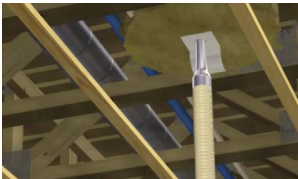
Innblåsing av løs isolasjon.....
